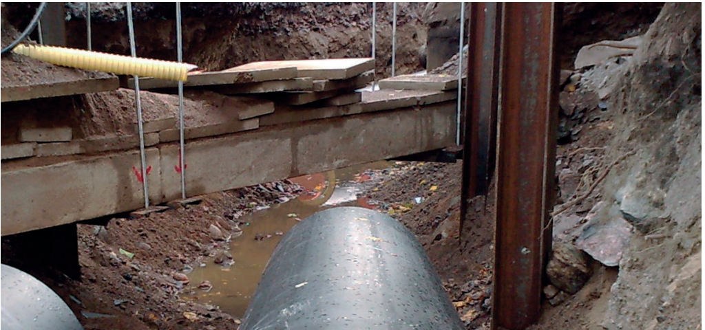
Kuva 1. 110 kV:n kaapelikanavan tuenta
